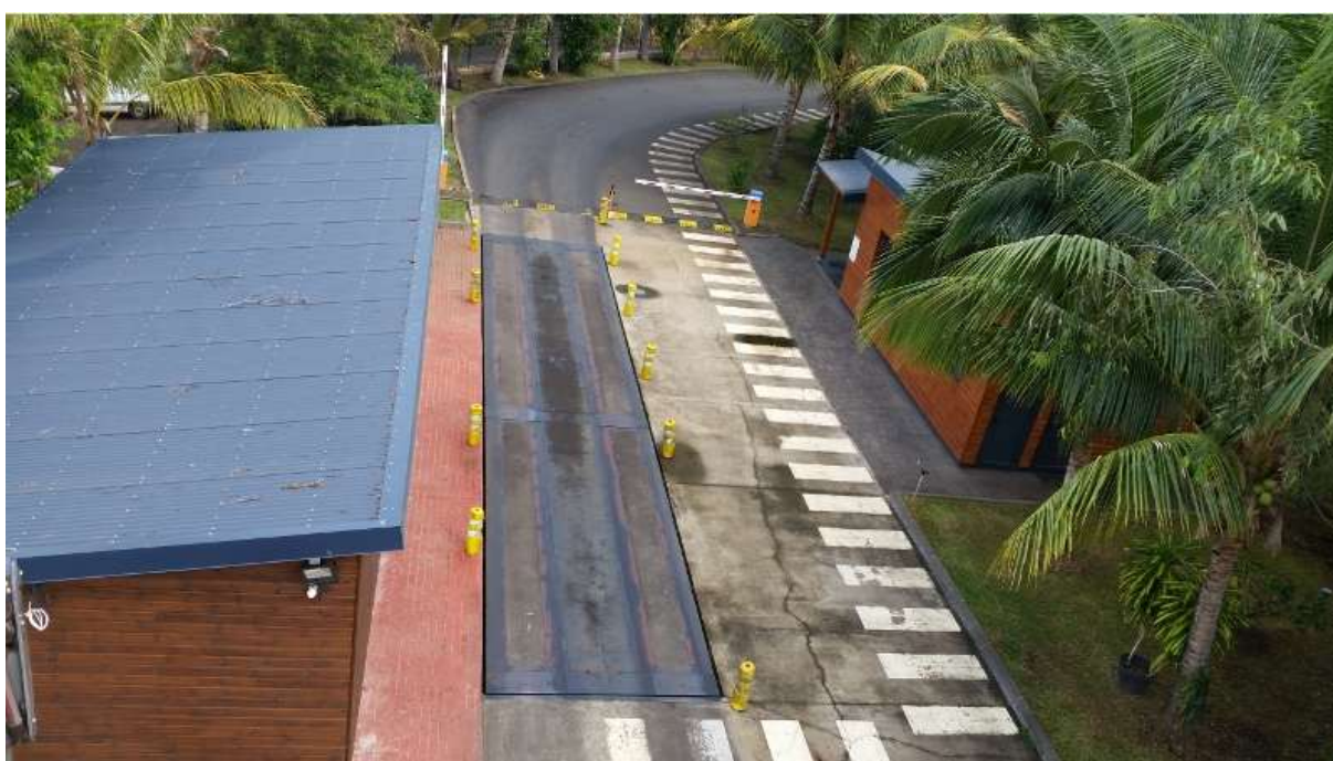
Zone d'accueil et pont bascule (crédit : RCO)
