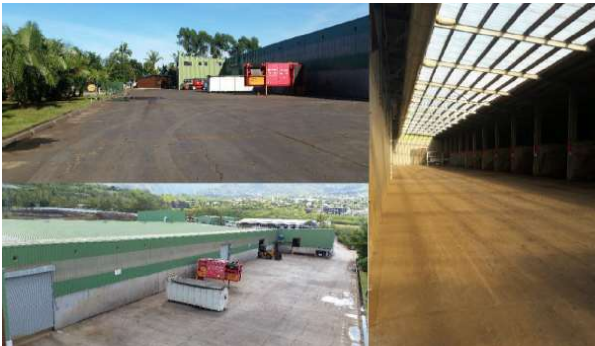
Bâtiment de fermentation (crédit : RCO)
