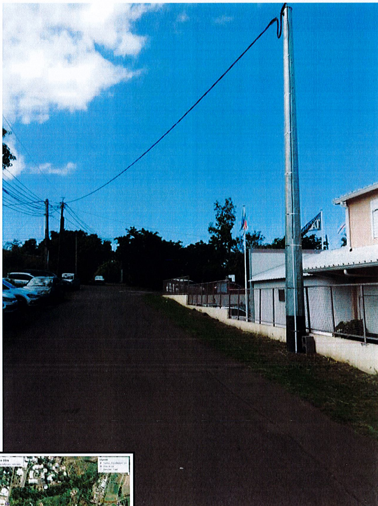
Photo vue 1 avant travaux
