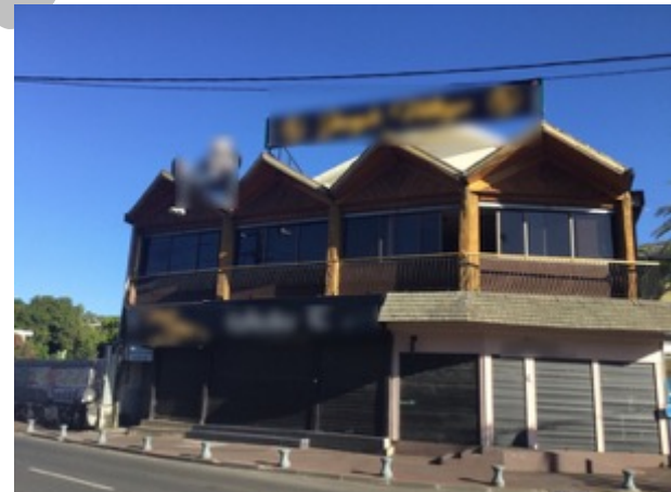
Enseigne sur toiture non conforme ayant un fort impact sur le paysage littoral, N2001
