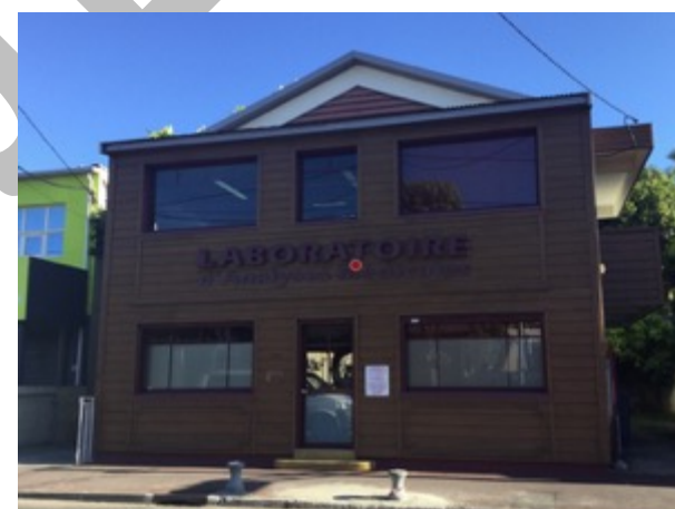
Enseignes parallèles bien intégrées au bâtiment, Saint-Gilles-les-Bains
