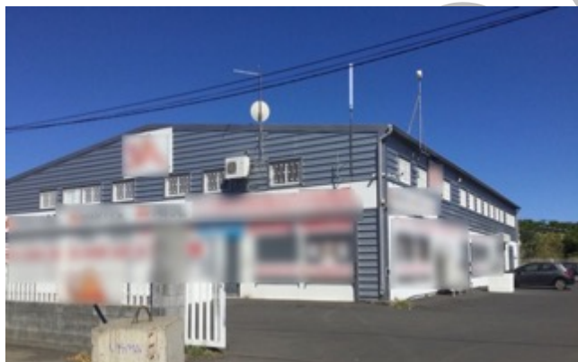
Surface d'enseignes en façade, rue du Kovil
