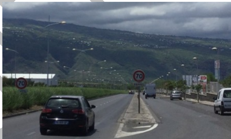
Vue de la N7 (route de Cambaie)
