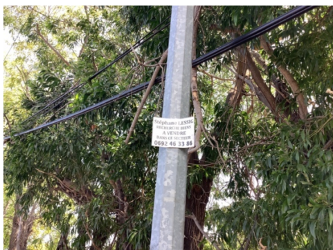
Préenseigne scellée au sol de petit format (<1m2) illégale, Saint-Paul, septembre 2022
