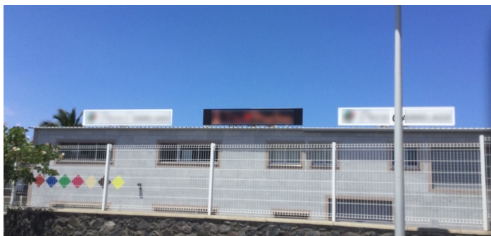
Nombreuses enseignes sur toiture non conformes, zone de Cambaie
