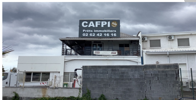
Enseigne sur toiture avec un panneau plein (illégal), Saint-Paul, septembre 2022
