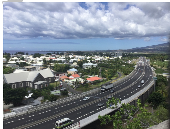
Enveloppe urbaine formée par la RN1 à l'Ouest
